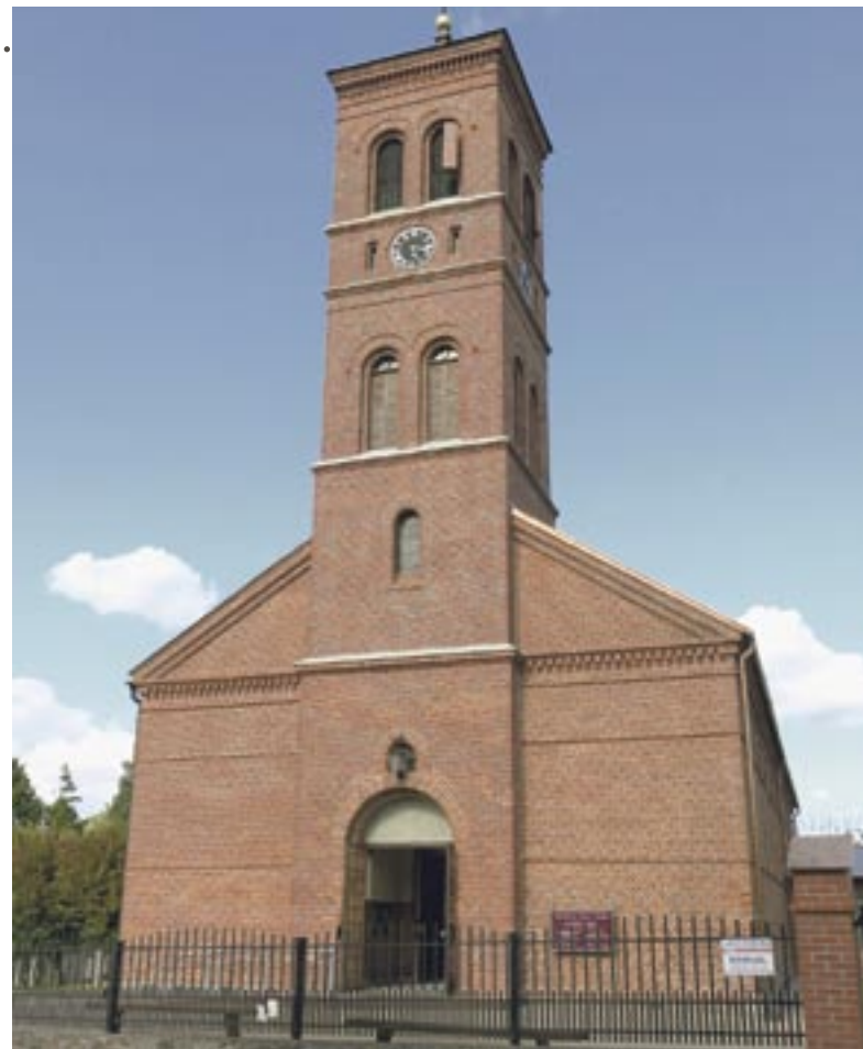
Chmielno. Kościół pw. św. Piotra i Pawła, widok od strony wieży.
