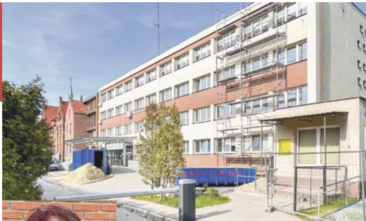
Szpital Pucki jest obecnie remontowany.
