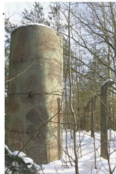
Tajemnicza betonowa wieża usytuowana w najwyższym punkcie Łysej Góry.
